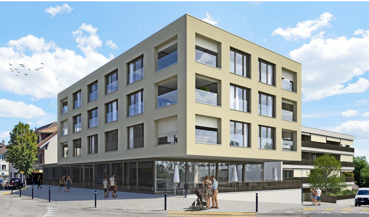
So wird sich der neue «St. Urs» im Frühsommer 2024 präsentieren. Foto: zlg.
