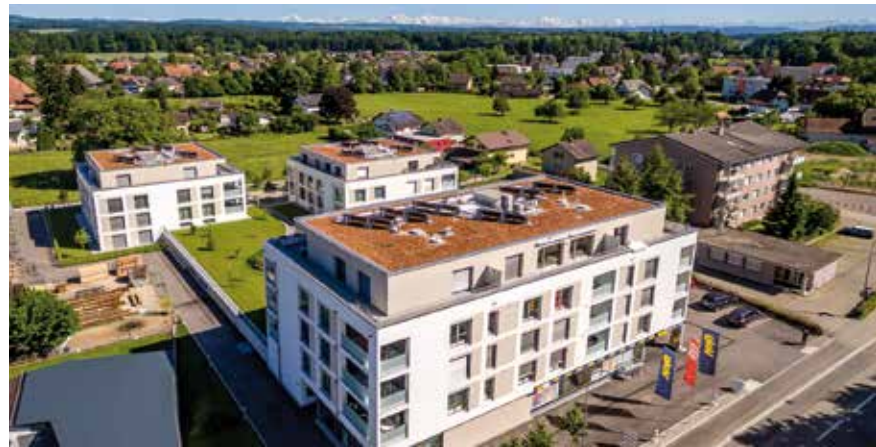
Dorfzentrum A, Recherswil
