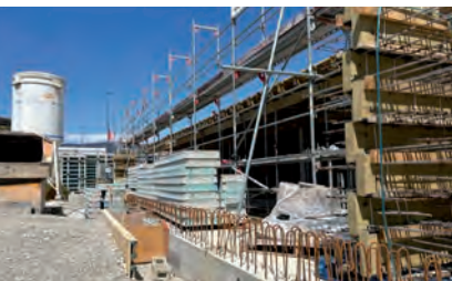
Neubauprojekt Biberist, St. Urs
