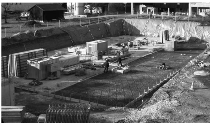
Egerkingen ein Neubauprojekt mit 3 Mehrfamilienhäusern und insgesamt 40 Wohnungen
